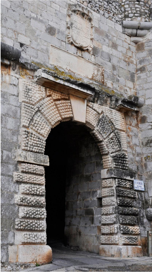
Figuras 12 y 13.- Portada de Felipe II. Vistas comparativas antes y después de la reciente restauración (IPCE. 2012), donde se aprecian los impactos y diversas patologías en los elementos de piedra.
