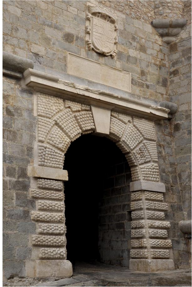
Figuras 12 y 13.- Portada de Felipe II. Vistas comparativas antes y después de la reciente restauración (IPCE. 2012), donde se aprecian los impactos y diversas patologías en los elementos de piedra.
