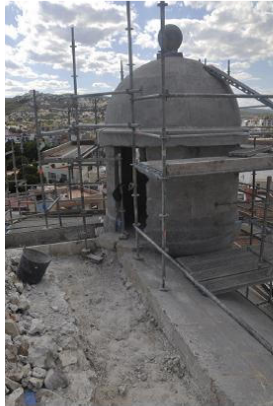
Figura 16.- Fotografía de la garita de Felipe II con muretes de mampostería sobre el parapeto en bocel del S. XVI que ahora se está restaurando e investigando
