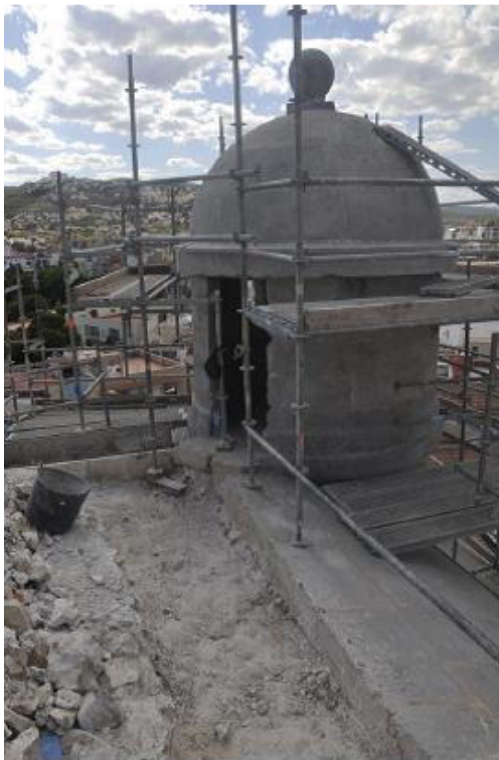
Figura 17.- Catas en la plataforma de la garita (2012)
